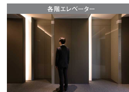
オフィスフロアの最終退出を確認後、当該階エレベーターを不停止制御します。
